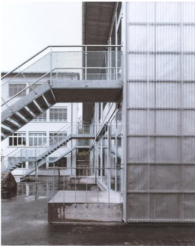
Durch die Wellplatten hindurch sieht man die Unterkonstruktion.
